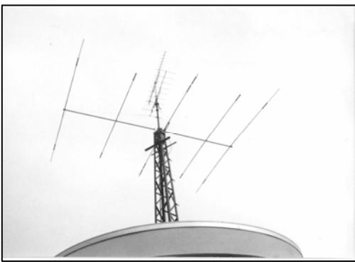
Die alte Antennenanlage (links), bestehend aus einer 25-Ele.-Yagi für 70cm, einer 12-Ele.-Yagi für 2m und einem FB53 von Fritzl für 20/15/10m mit einem Speziell angefertigten Rotor-System zum getrennten Drehen der UKW und KW Antennen wird durch eine Log-Periodische Kurzwellenantenne für 10m bis 20m und je einer Yagi-Antennen für 2m und 70cm sowie eine Groundplane für 2m, 70cm und 23cm ersetzt (rechts).
